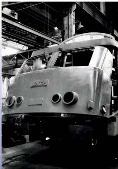
Photo : Mise en place du masque frontale sur une BB-67400 - Coll. B. Bayle
